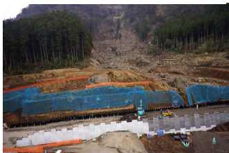
災害復旧工事
